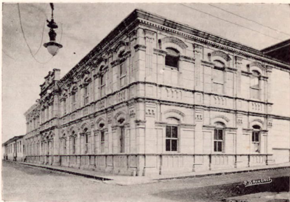
Escuela Normal instalada en la Ciudad de Heredia.
