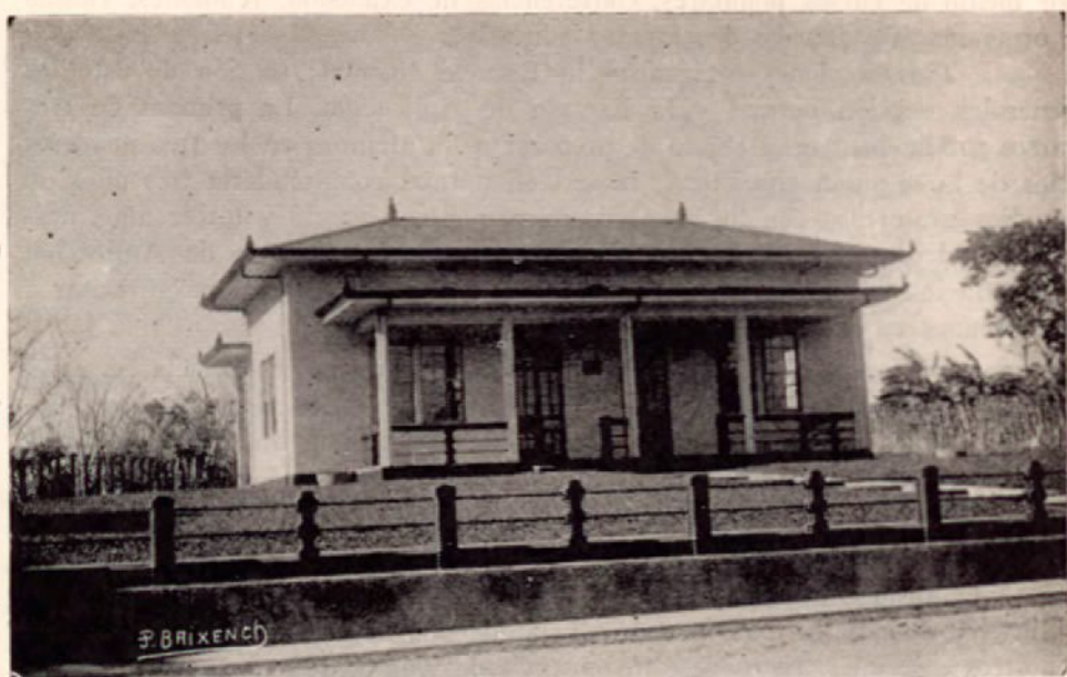
Escuela del distrito de Las Animas, en la Provincia de Alajuela. En casi todas las pequeñas poblaciones del país se ha adoptado este modelo de construcción que ofrece singulares ventajas a los alumnos, que disponen de suficiente aire y luz, así como de bastante espacio para su desarrollo físico.
