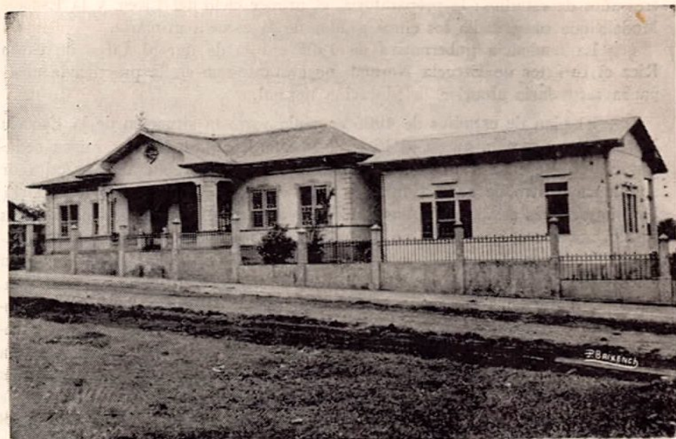
Hermoso edificio escolar construido en el distrito de San Isidro de Heredia. Es uno de los mejores ejemplares de las Escuelas modernas, que se admiran en todas partes como obra positiva del Gobierno.
