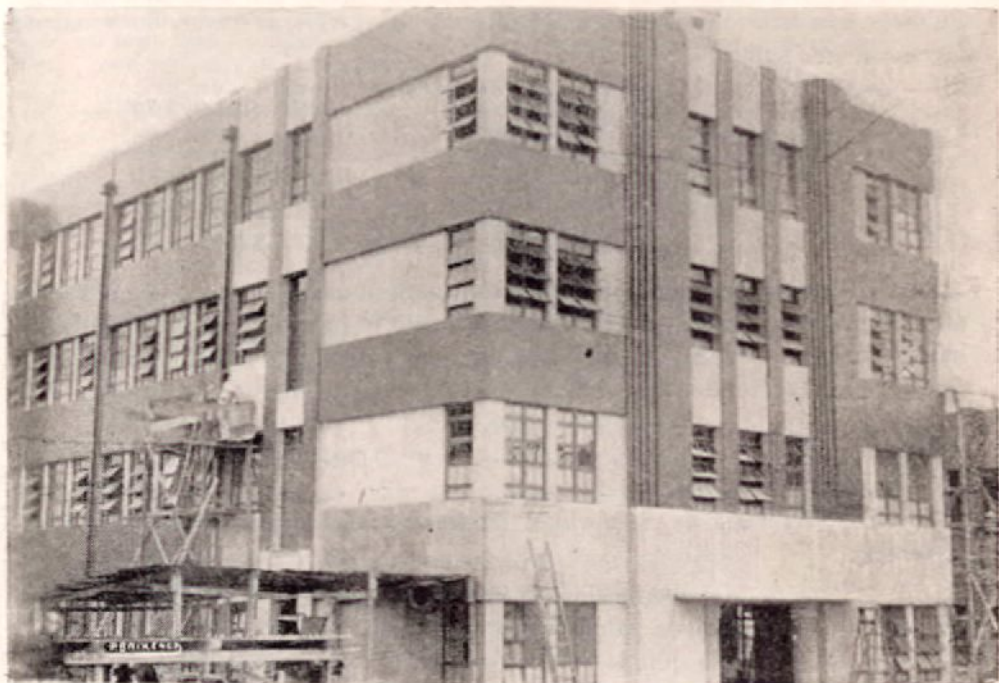
Edificio de Salubridad Pública, inaugurado recientemente y en el cual se alojan todas las dependencias de esta importante Secretaría de Estado.
